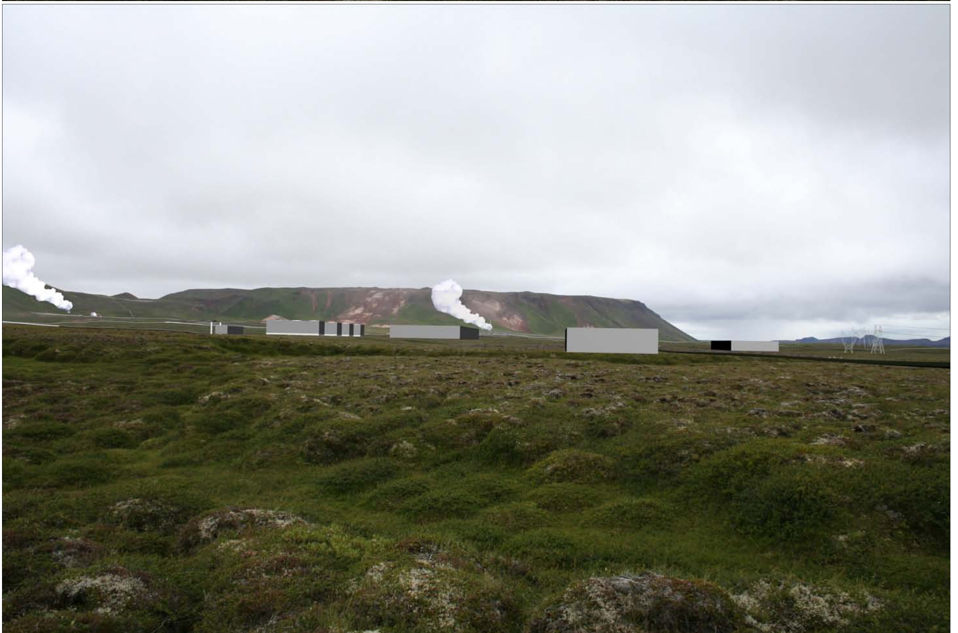
Mynd 6.16 Þeistareykjavirkjun. Horft í átt að Bæjarfjalli frá stað skammt norðan fyrirhugaðs stöðvarhúss. Á neðri myndinni sjást mannvirki á stöðvarhúsreit fyrirhugaðrar virkjunar. Fyrirhugaðar háspennulínur koma að virkjun hægra megin á mynd. (Tilvísun í mynd 6.11 – 756).
